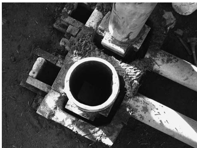
Două sobe-rachetă alăturate într-o versiune experimentală cu conducte de căldură ascendentă din oțel în loc de cărămidă. Fortărețele de cărămidă ridicate în jurul tunelurilor de ardere formează structura de susținere pentru butoaiile radiante, precum și ca incintă pentru gazele care curg în josul butoaielor înspre burlane și coșul de fum, la dreapta. Cărămizile și partea de jos a butoaielor vor fi etanșate pe exterior cu cob.
