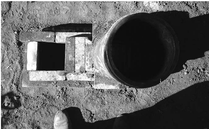
Vedere de sus a butoaielor pentru tubul de alimentare și conducta ascendentă de căldură.
